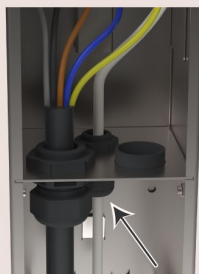
Afbeelding16: zicht op de openingen voor de kabeldoorvoer
