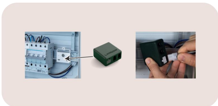
Afbeelding 4: Zicht op een distributiepaneel met DIN-bevestigingsplaat en Power Box
