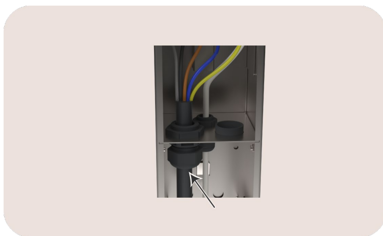
Image 16 : Vue sur les trous pour l'entrée du câble
