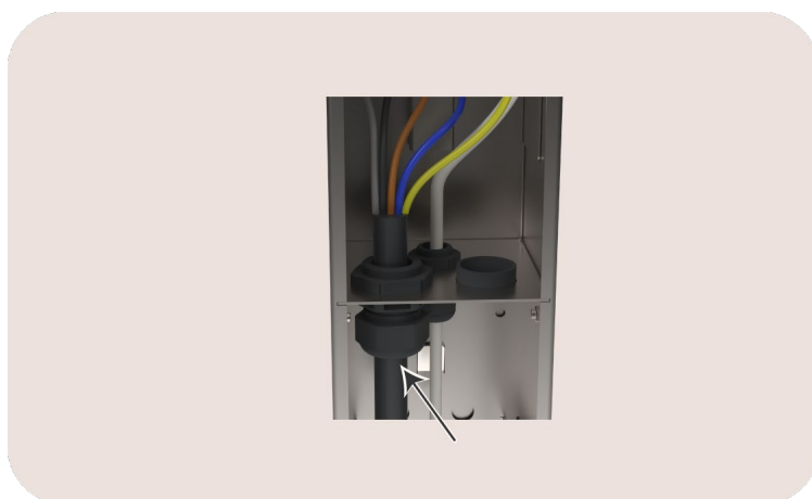
Afbeelding16: zicht op de openingen voor de kabeldoorvoer
