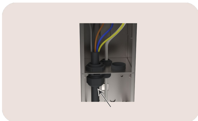
Image 17 : Vue sur les trous pour l'entrée du câble
